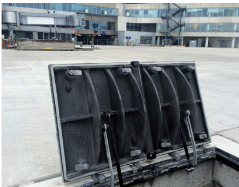
Kabelschachtabdeckung tagwasserdicht mit Stahlbetonrahmen, Klasse F 900, Frankfurt
