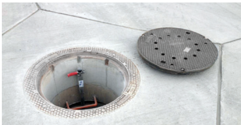
Gussabdeckung mit Schraubvorreiber-Verschlüssen Klasse F 900, lichte Weite 800 mm
