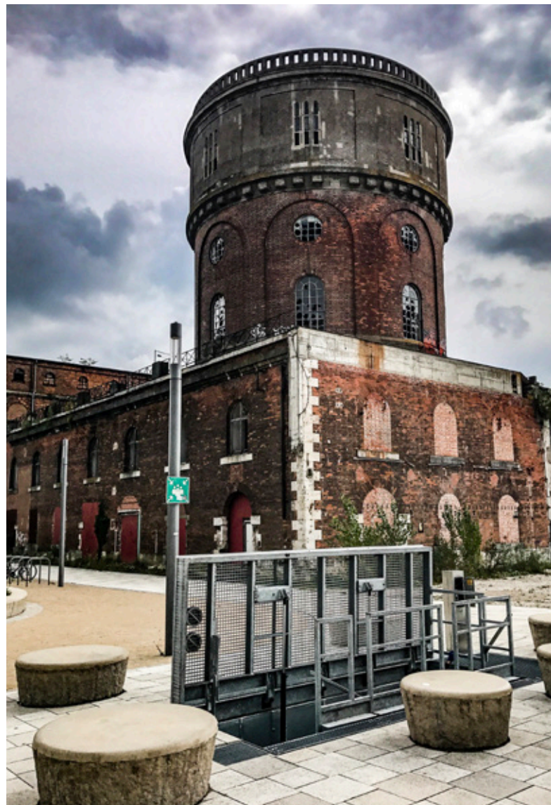
Notausstieg mit hydraulischem Antrieb als Gitterrost, Ingolstadt
