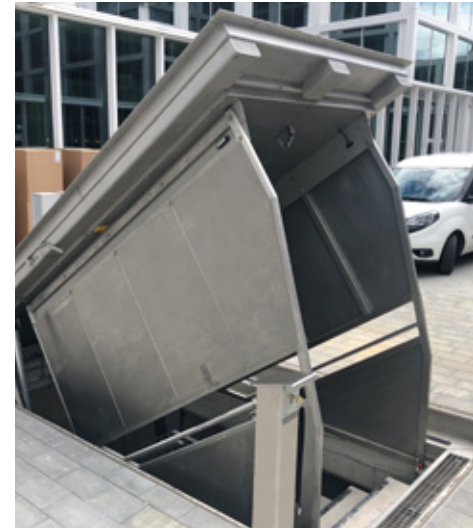
Hydraulisch betätigte Notausstiegabdeckung, Stuttgart
