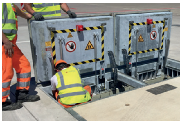
Schwerlastabdeckung mit zwei Revisionsöffnungen, Klasse F 900
