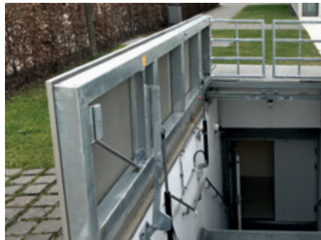
Großformatige, rechteckige Abdeckungen auf Bauwerksöffnungen
