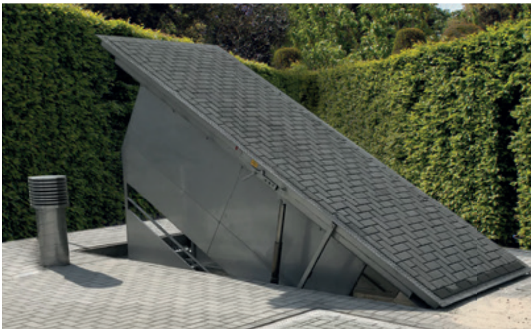
Einstieg in Pumpwerk, Seligenstadt
