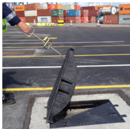
Öffnen der Dreiecksdeckel, Klasse F 900, Hamburg
