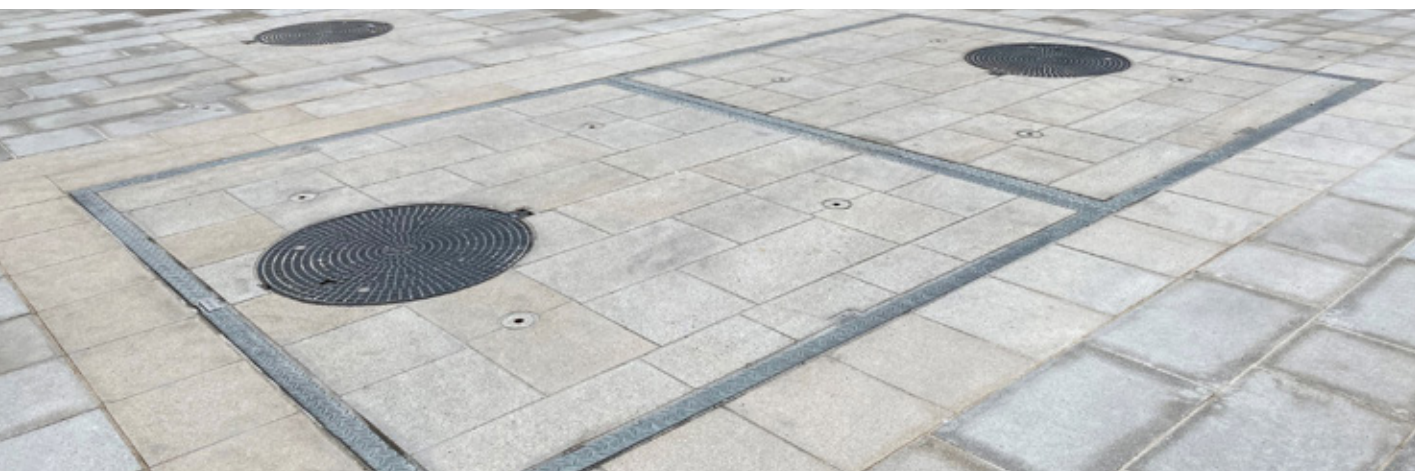
Unterirdische Bahnstation mit Ein- und Ausbringöffnungen für die Entrauchungstechnik und Revisionsöffnungen für den schnellen Zugang, Innenstadt Karlsruhe
