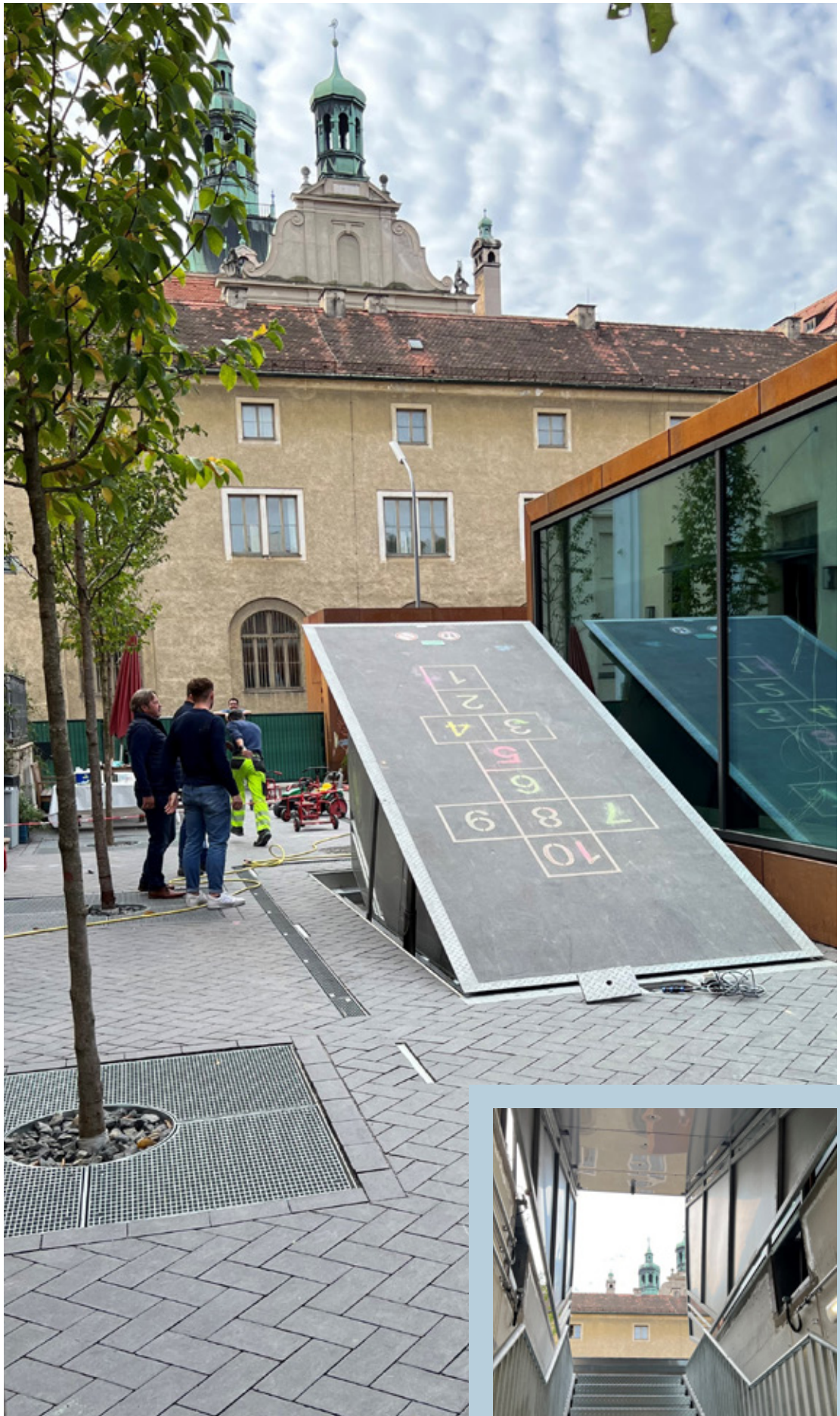
Automatische Öffnung auch bei Stromausfall durch hydraulische Druckspeicher mit integrierter Notstromversorgung, Archäologische Staatssammlung München
