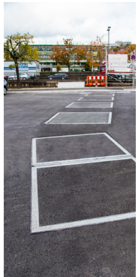
Rückstausichere Abdeckungen mit Asphaltfüllung, Ansbach
