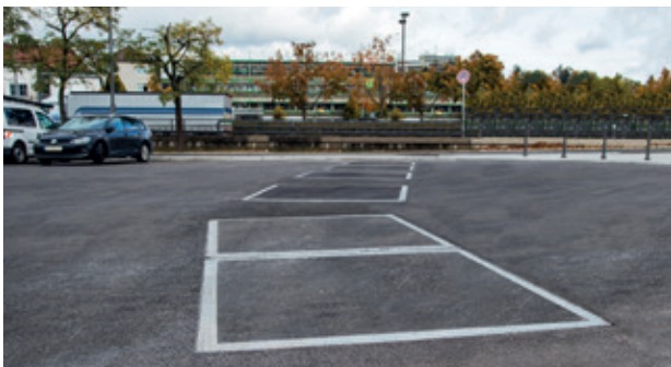
Rückstausichere Abdeckungen mit Asphaltfüllung, Klasse D 400, Ansbach
