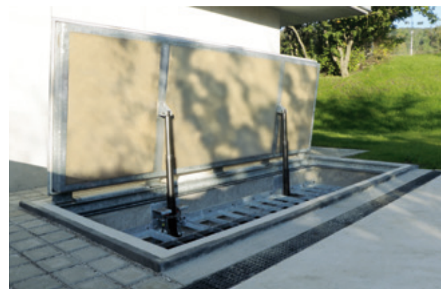
Hydraulische Abdeckung auf Holzhacksnitzelbunker mit Brandschutzklasse F90, Eisenstadt/Österreich
