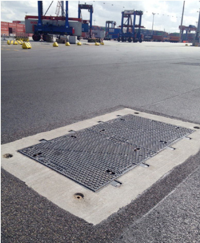
Gussabdeckungen mit Dreiecksdeckeln und Fertigteilrahmen, Klasse F 900
