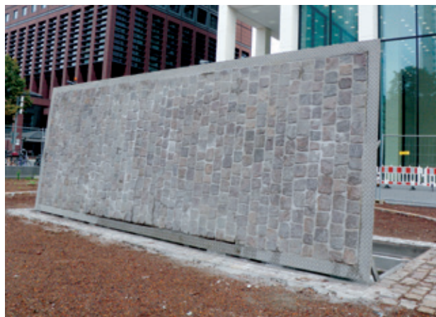
Notausstieg mit ausgepflastertem Deckel, Frankfurt
