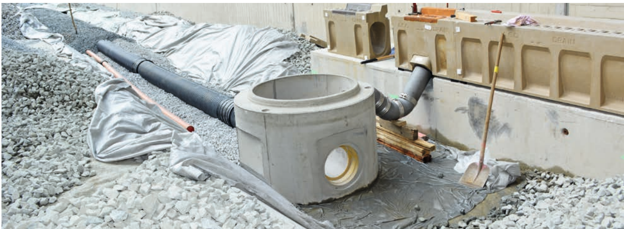
Anschlusselement mit Rohrsiphon zum Revisionsschacht und Anschluss an die Längsentwässerungsleitung
