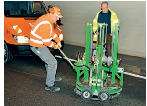
Ziehen des alten Rahmens der Schachtabdeckung
