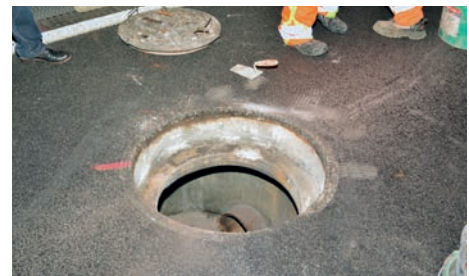
Die alte Abdeckung wurde entfernt und der Schacht wurde für den Einsatz der neuen ACO Schachtabdeckung Multitop vorbereitet
